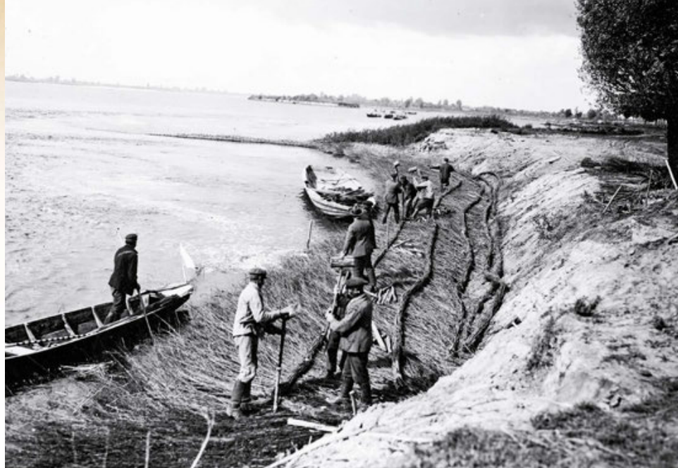
Robotnicy przy umacnianiu brzegów Wisły faszyną, 1927 r.
