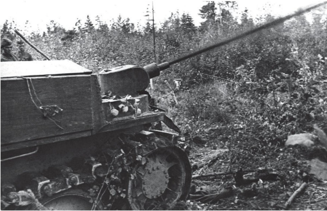
▼ Le Flammpanzer II ( Sd. Kfz. 122 ) – aussi désigné Panzer II (Flamm) ou Panzerflammwagen – est doté de 2 petites tourelles ( Spitzköpfe ) disposées sur l'avant du blindé et installées de chaque côté de la caisse, au-dessus des chenilles, accueillant chacune un tube lance-flammes. Théoriquement, ce dernier projette un maximum de 80 jets enflammés d'une durée de 2 à 3 secondes à plus de 36 mètres (25 mètres en pratique).
