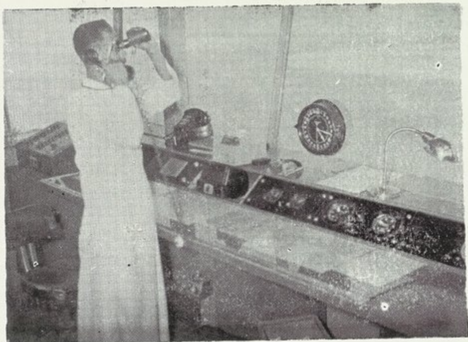
برج المراقبة بمطار جدة
