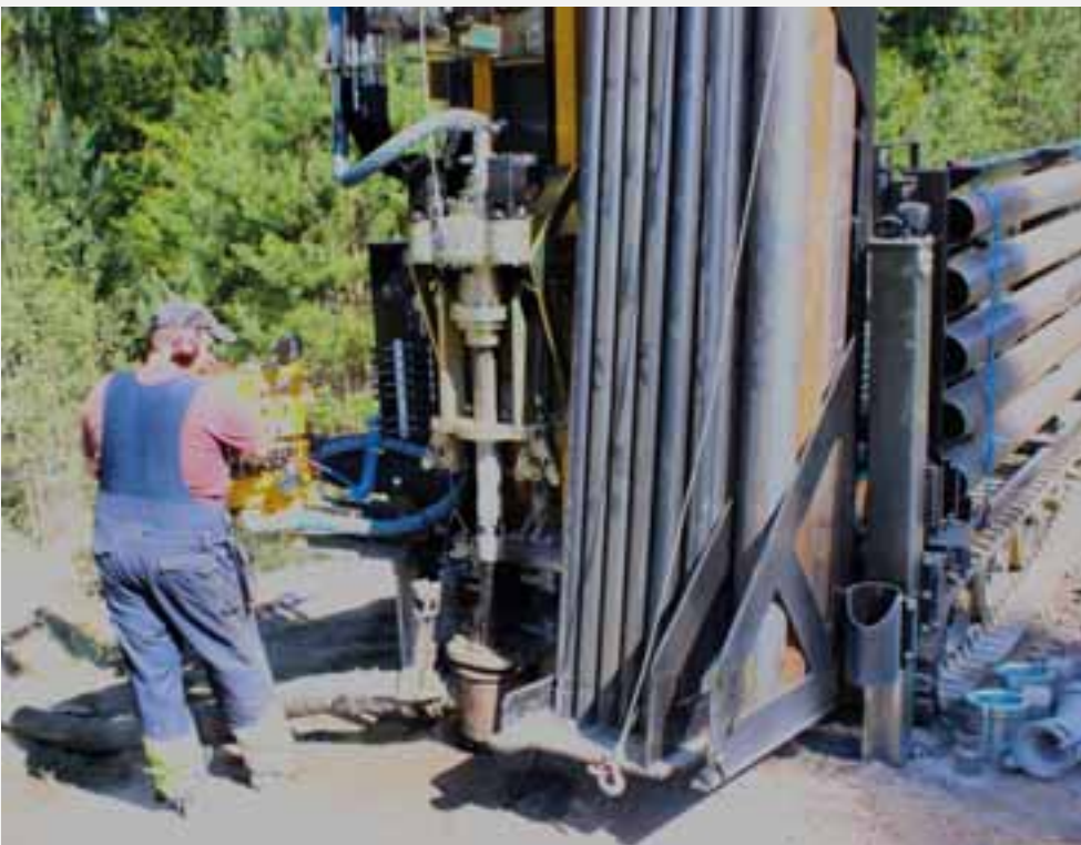
Koneen mukana kulkee 30 metriä maaputkia ja yli 200 metriä poratankoja.
