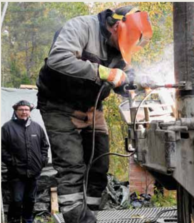
Jukka Stenberg hitsaa maaputkea. Tarmo Kallioniemi seuraa arvioijana työn sujumista.
