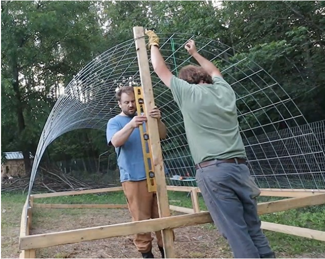
FIG 24. PLUMBING DOOR FRAME
