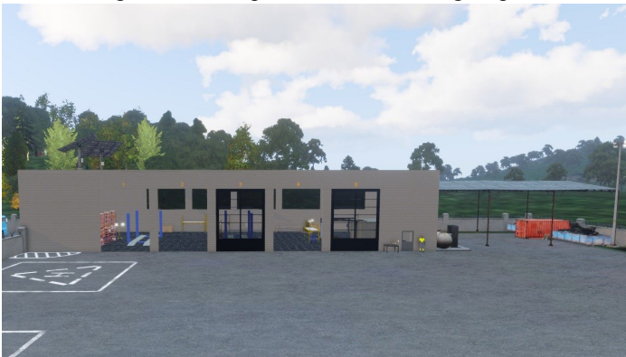
Bildinhalt: Rechts: Die Werkstatthalle; Links: Unterstellplatz mit Material
