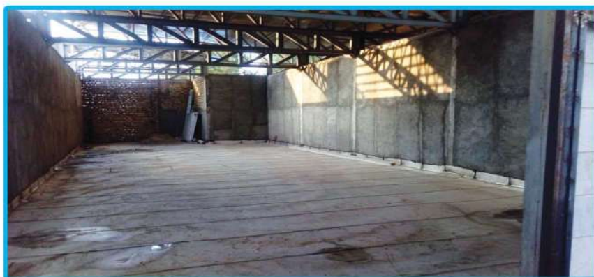
• اجرای ایزوگام کف
