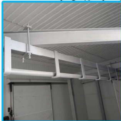
• نصب پنل دیوارهای پیش سردخانه
