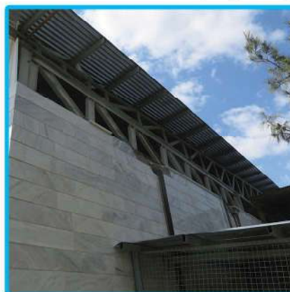
• اجرای نمای سقف شیروانی
