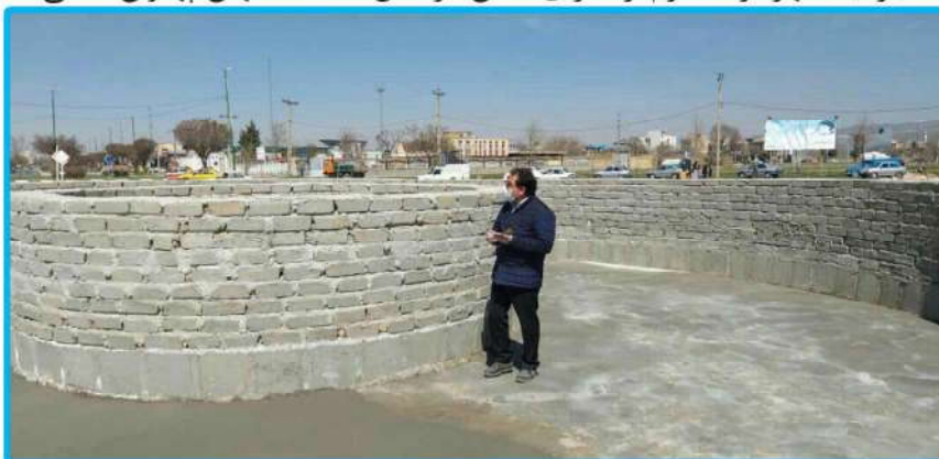
بازدید شهردار محترم از اجرای فنداسیون میدان امام (ره)
