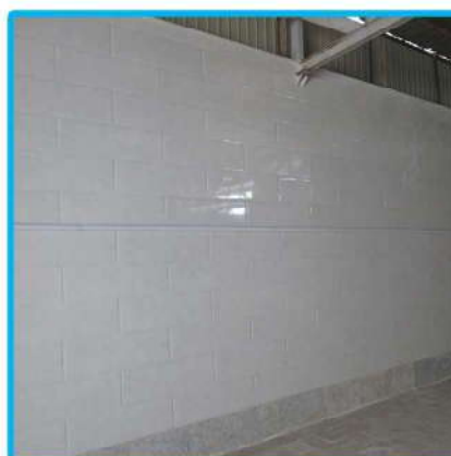
• اجرای کاشی کاری دیوارهای سالن شماره ۲
