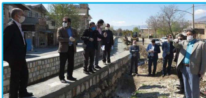
بازدید از عملیات بهسازی نهر انتهای خیابان بهارستان
