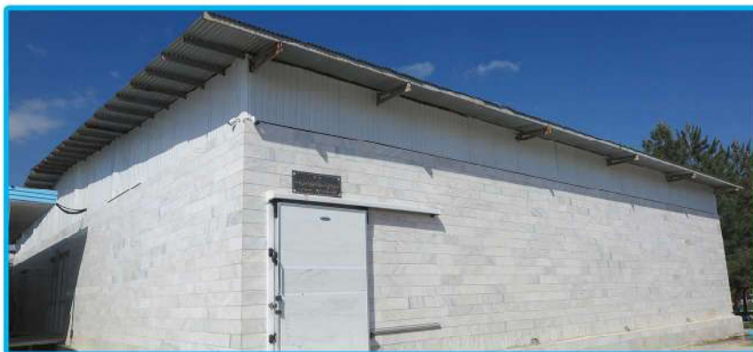
• اجرای نمای سقف شیروانی سالن شماره ۲
