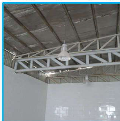
• اجرای نمای سقف شیروانی سالن شماره ۲
