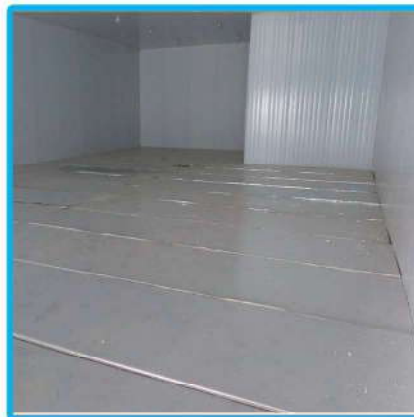
• اجرای ایزوگام کف سالن شماره ۲
