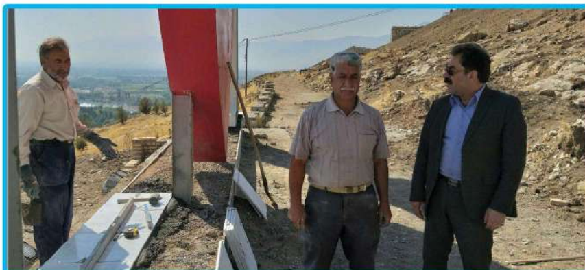
بازدید از عملیات عمرانی احداث مسیر دسترسی پارکینگ جدید تپه چغا
