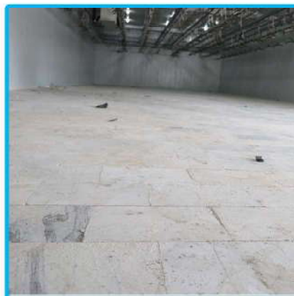
• اجرای سنگ فرش و کاشی کاری سالن پیش سردخانه
