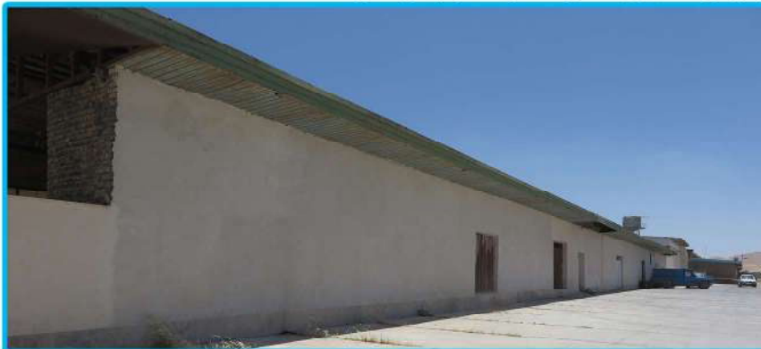
• اجرای دیوار کشی
