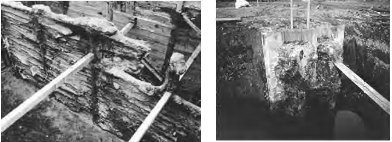
Hình 1.1: Jet Grouting được áp dụng ban đầu để tạo tường ngăn nước (Essler & Yoshida 2004).
