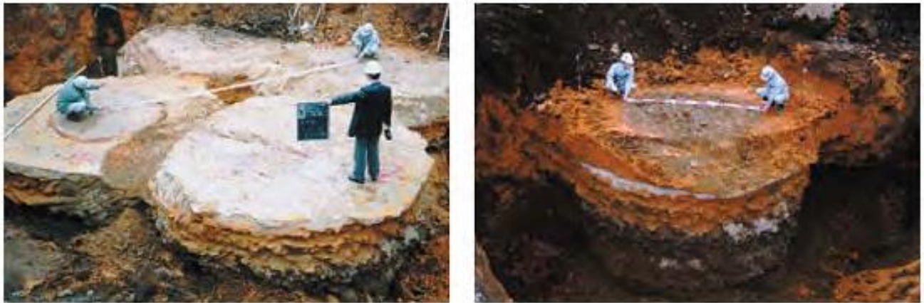
Hình 1.2: Cột vữa thi công bằng công nghệ SupperJet Grouting với đường kính trên 4m (Kazemian&Huat 2009 từ nguồn Ratio 2006)
