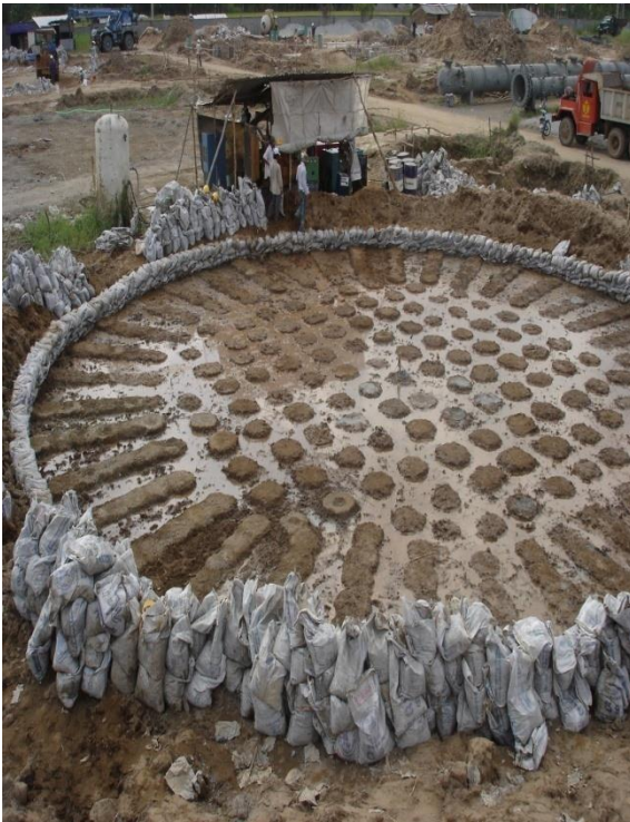
Hình 1.11b. Gia cố cọc xi măng đất móng bồn dầu tại Cần Thơ
