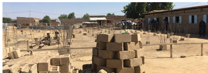
Eglise Farcha // travaux potentiels
