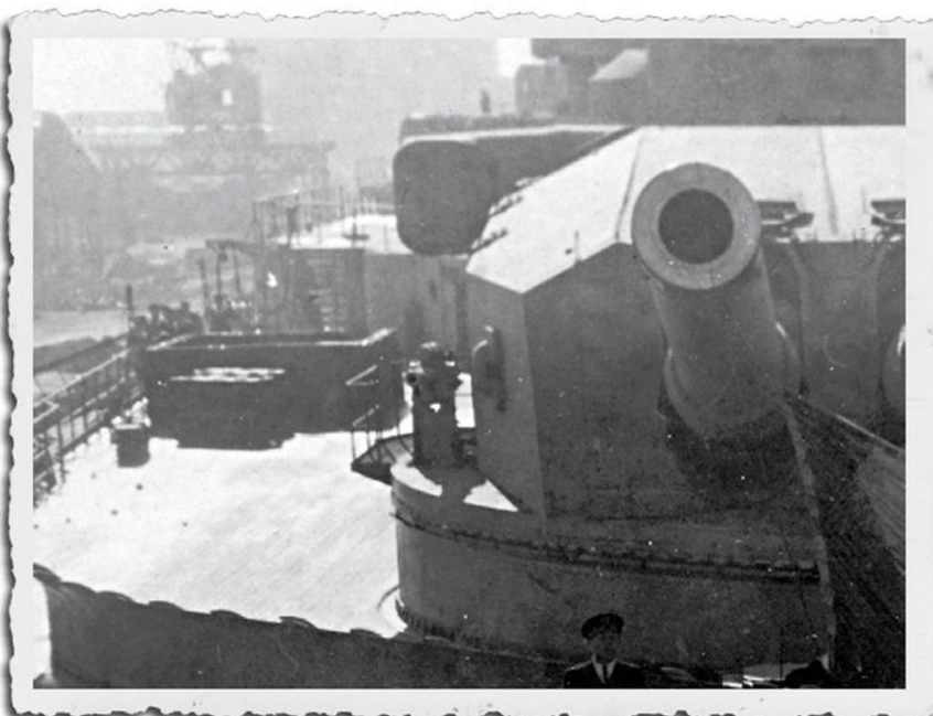
Vue en gros plan d'un canon de 380 mm du Jean-Bart . On remarque le canon de 90 mm installé sur le côté tribord de la tourelle.
