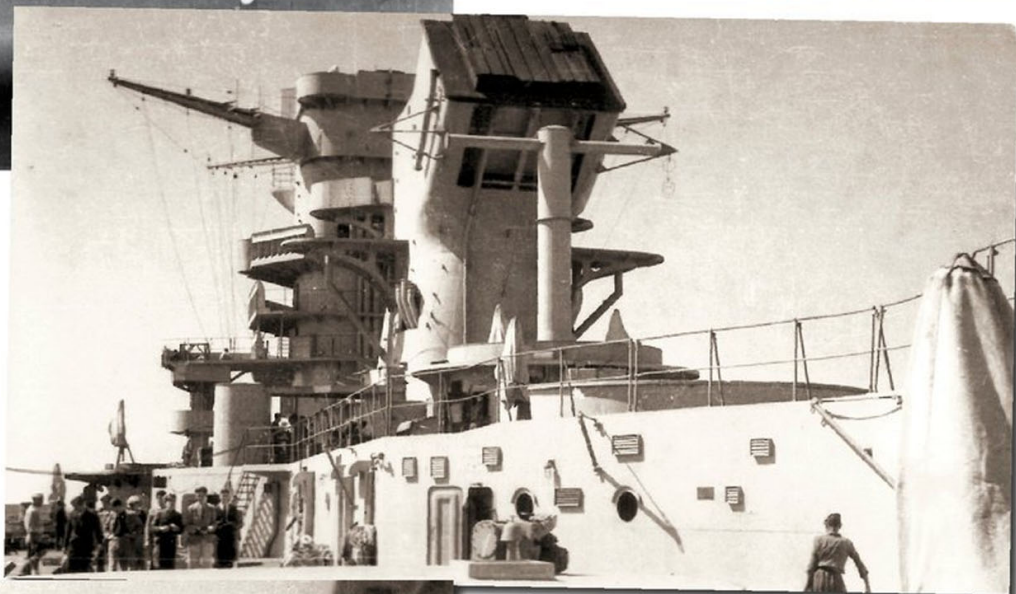
La cheminée et la tour du Jean-Bart en avril 1942. Les deux télépointeurs hérités du Dunkerque ne sont pas encore installés sur les côtés de la tour et une partie de la DCA manque toujours. (Dr. Thierry via Robert Dumas)
