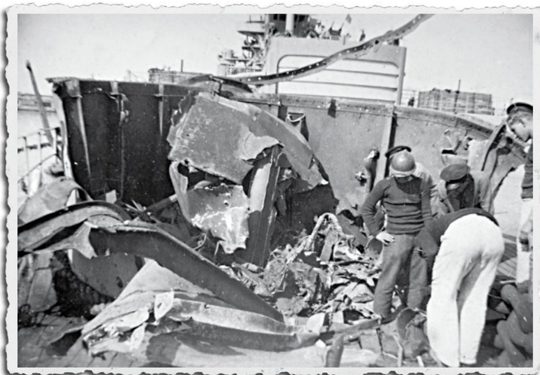
Des marins fouillent les tôles déchiquetées de la plage arrière, au niveau des fûts de catapultes.
