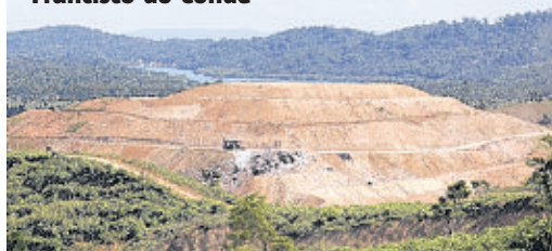
Aterro em São Francisco do Conde
