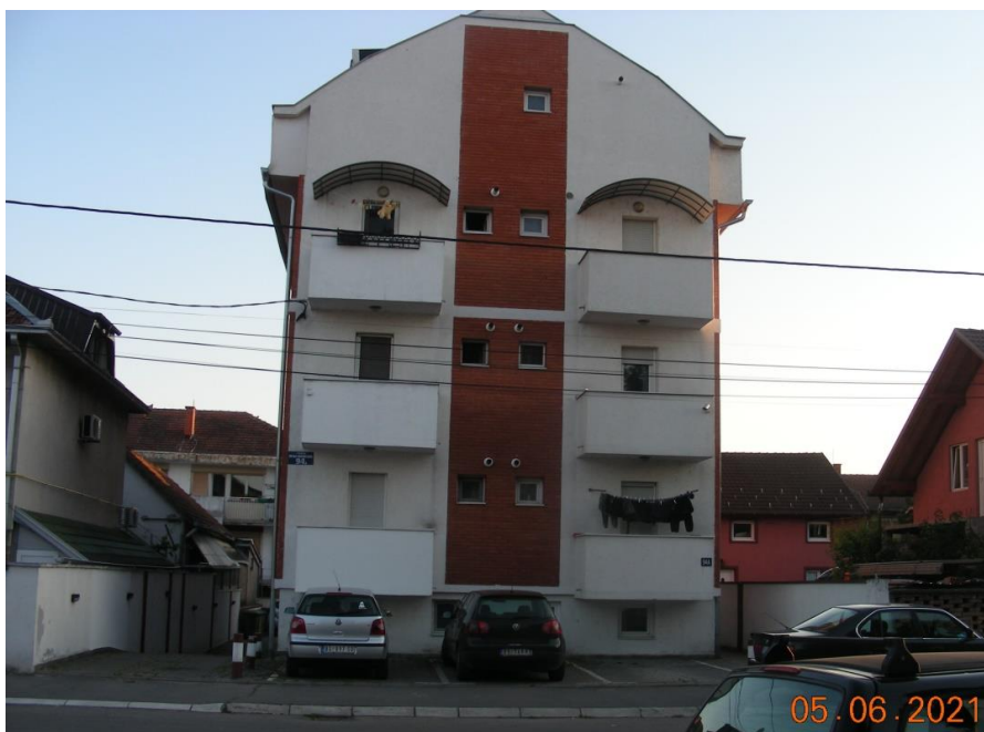
Слика 5. Улични изглед једне од зграда описаног типа трансформације (Батајница)
