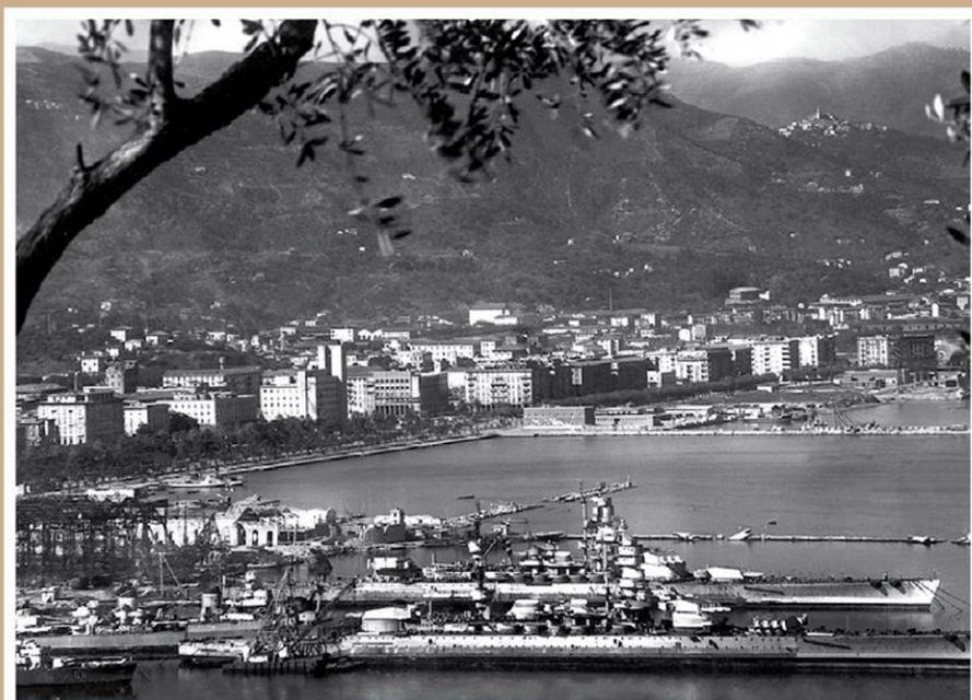
◀ Le Vittorio Veneto et l' Italia (ex- Littorio ) à la Spezia au début des années 1950. Les opérations de démantèlement ont commencé, les fûts des canons ont été coupés, les cheminées arasées. En 1968, c'est le Richelieu qui sera démoli au même endroit par les ferrailleurs italiens.
