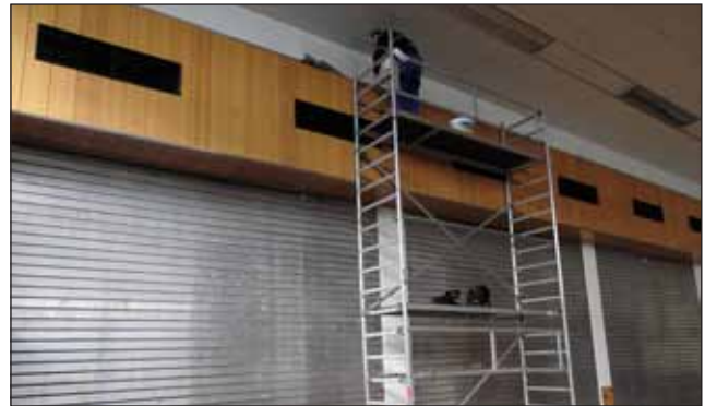
Glasbausteine nach der Verkleidung
