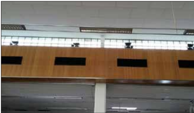
Glasbausteine vor der Verkleidung
