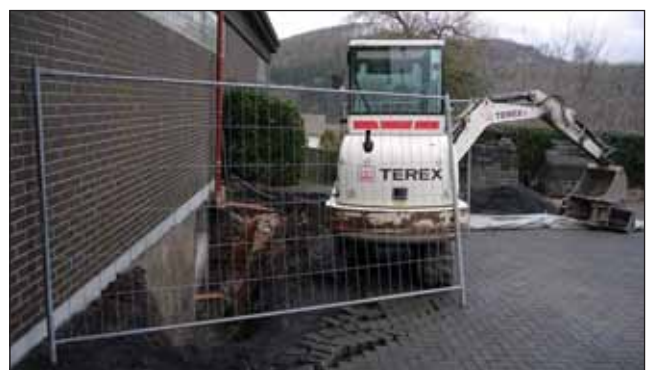
Freilegung der Außenwand
