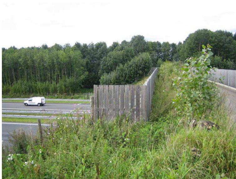
Rysunek 5.1.10.7-3 Ekodukt z roślinami kwiatowymi przyciągającymi owady jako przejście dla nietoperzy nad drogą – rysunek poglądowy.
