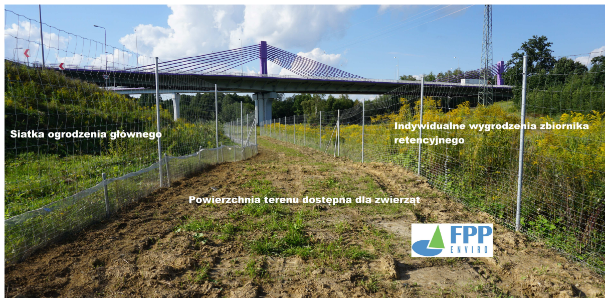
Fot. 1 Widok na wygradzenia siatki ogrodzenia głównego oraz indywidualne wygradzenie zbiornika retencyjnego pozostawiając powierzchnię dostępną dla zwierząt na przykładzie mostu na rzece Kolejówka, autostrada A1. Materiały własne FPP Enviro (lipiec 2014r).
