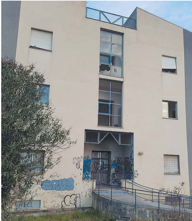
Corso del Popolo La palazzina deve essere ancora bonificata dal Comune
