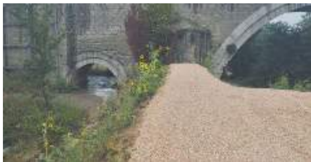
Problemi di accessibilità Gli argini sul Tevere: sopra nascerà la pista ciclabile
