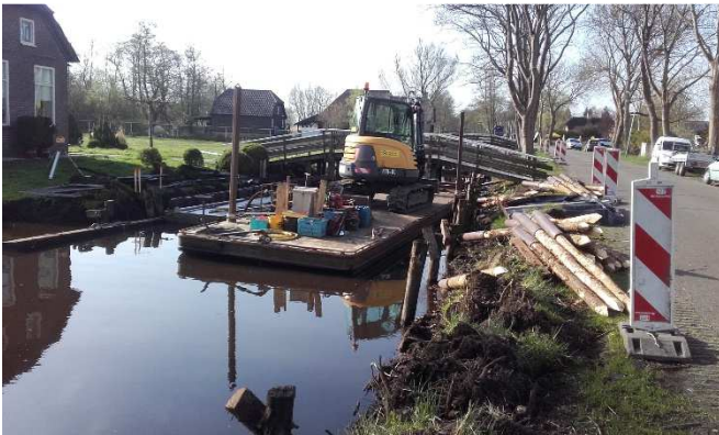
Vervangen beschoeiing dorpsgracht Giethoorn
