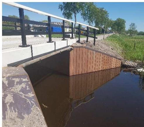
Brug BSBV20 + BSBV25: de houten brug is vervangen door een betonnen brug
