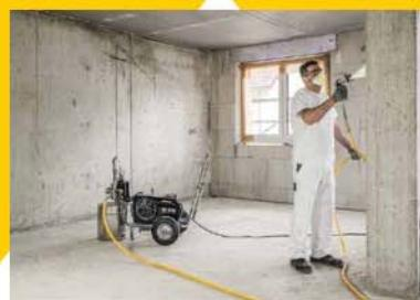
Kvalitetno prskanje: pištolj visokih performansi AG 14. Kada se koristi kombinacijom sa 2SpeedTip mlaznicom moguće je bez problema obraditi čak i materijale visokog viskoziteta
