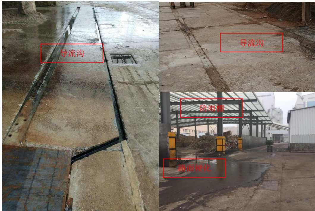
图 4.4-6 硬化、导流沟及防雨棚
