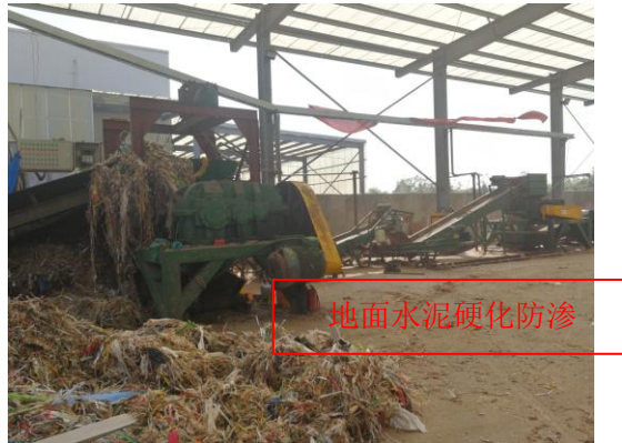
图 4.5-31 生产区地面硬化
