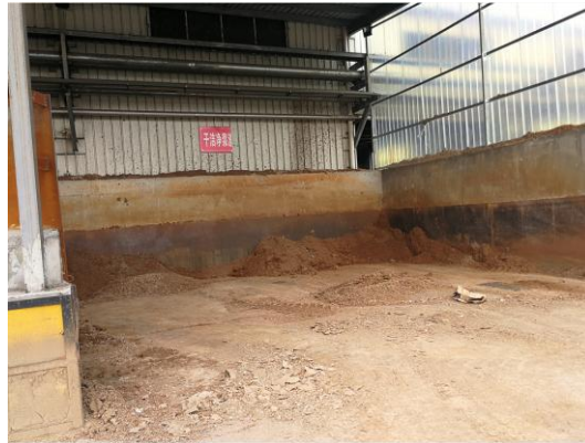
图 4.4-3 洁净浆渣堆放区
