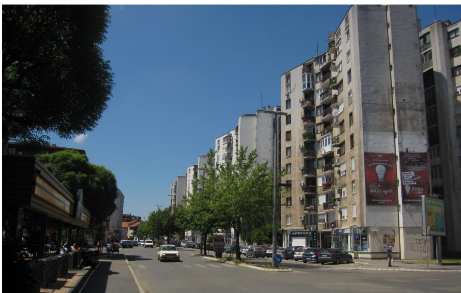
слика 2. - данашњи изглед Улице Гаврила Принципа
