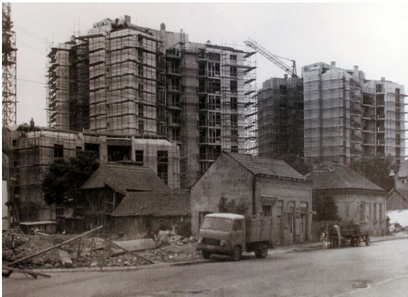
слика 1. - изградња "бијелих зграда"
