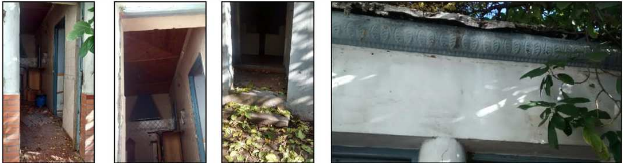
Sector 1: Cubierta con perfiles metálicos y madera. Solado de baldosas calcáreas. H.: 2.70m.
