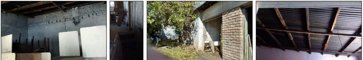
Sector 2: Estructura de perfiles metálicos y madera. Cubierta de chapa acanalada. H.: 3.00m.
