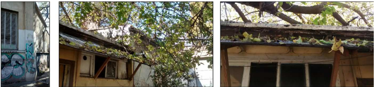
Sector 3: Cubierta de madera, cabios y machimbre. Cubierta de chapa acanalada. H.: 3.50m. Solado: contrapiso y baldosas calcáreas.
