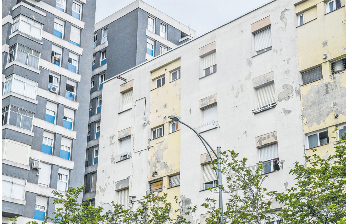
Blocs d'habitatges a les Termes / LLUÍS FRANCO
