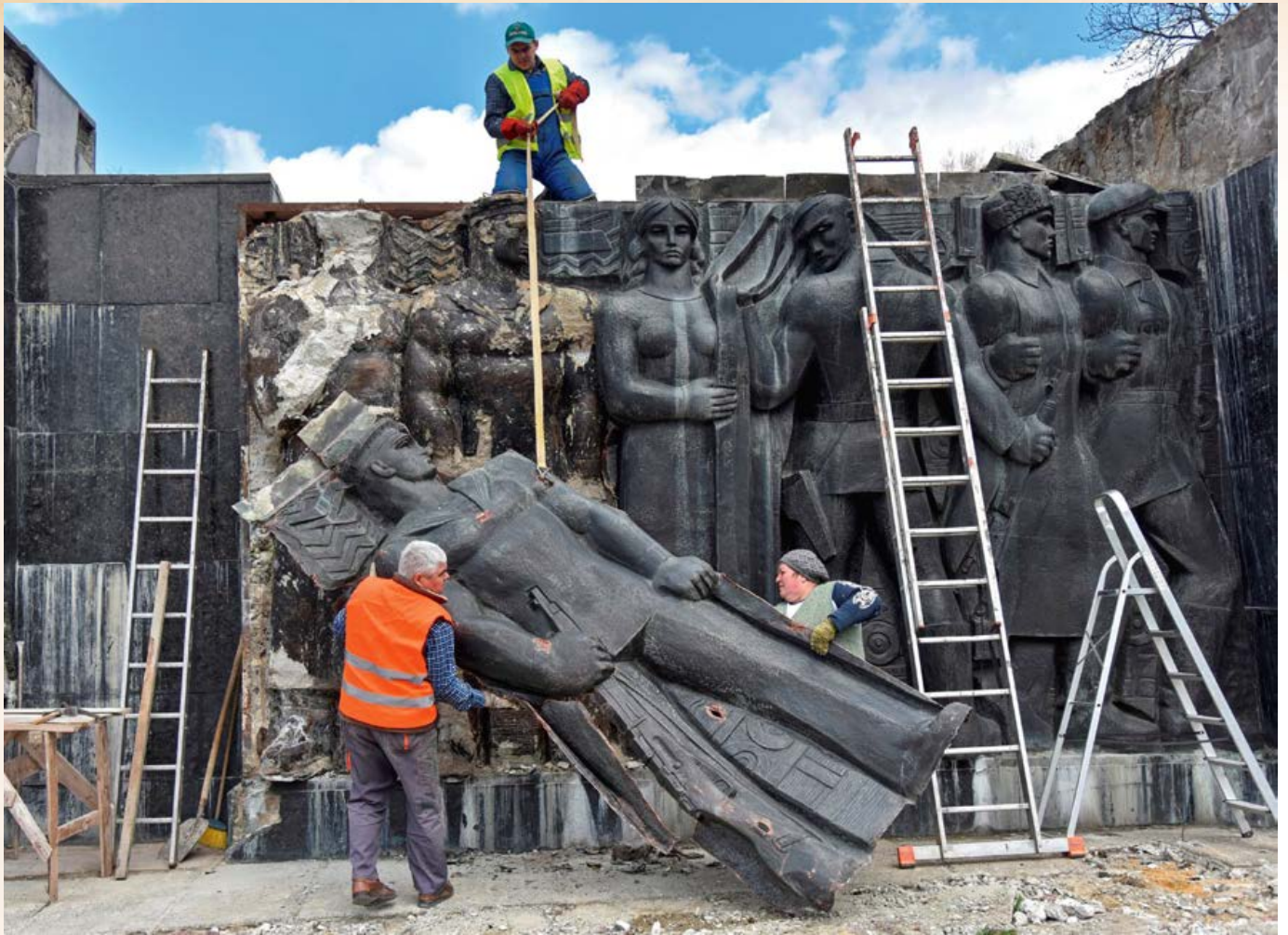
Demontaż płaskorzeźby z pomnika Chwały Wojennej Armii Radzieckiej we Lwowie, 23 kwietnia 2021 r.
