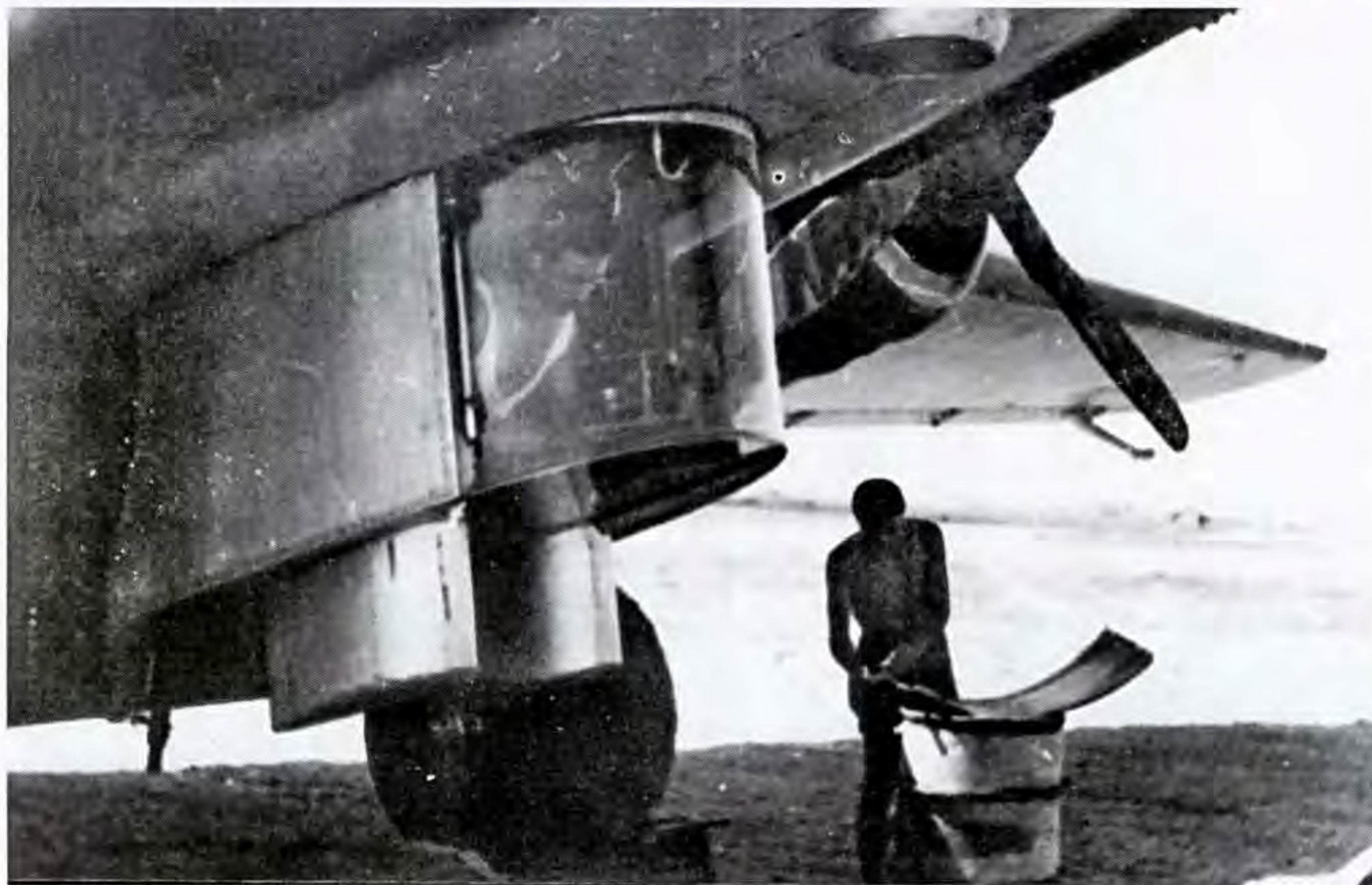
A sinistra e sotto: postazione difensiva ventrale retrattile e per il dispositivo di puntamento Jozza U.3. Sotto: la postazione del puntatore in posizione retratta. Nella pagina a fianco: una formazione mista di SM.82 ed SM.75 bis.
