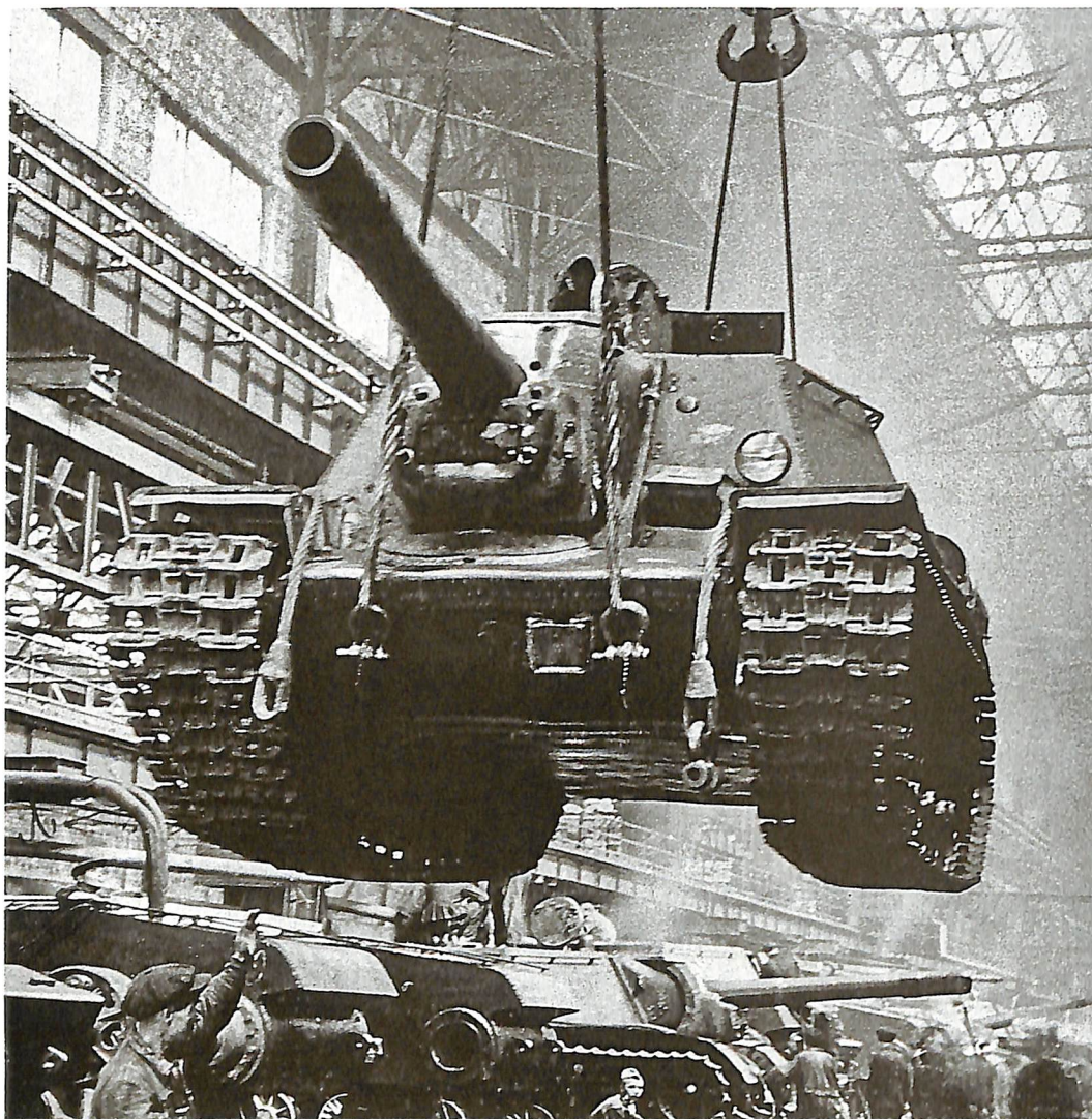
▲ Le Samokhodnaya Ustanovka 152 (version automotrice ou encore affût autopropulsé) reprend le châssis du char lourd KV-1 (S pour Skorotsnoy ou rapide dans la langue de Molière). Bien qu'il soit, en 1943, le seul engin de sa catégorie au sein de l'arsenal soviétique, la cuirasse du KV-1 est battue par le 8,8cm du Tiger I et il n'apporte donc rien de plus au combat que le T-34 armé de la même pièce. Coll. Arkady Moves
