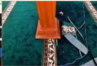
Pemotongan coakan tiang dengan rapi & presisi
