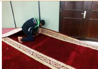
Pemotongan karpet sesuai dengan bentuk ruangan
