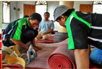
Proses Penyambungan dengan lem khusus
