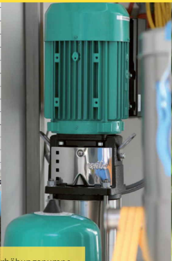
Anschluss zum Tankfahrzeug und Druckerhöhungspumpe
