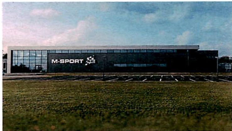
Direkt am Flughafen Krakau: 4000 Quadratmeter Nutzfläche
