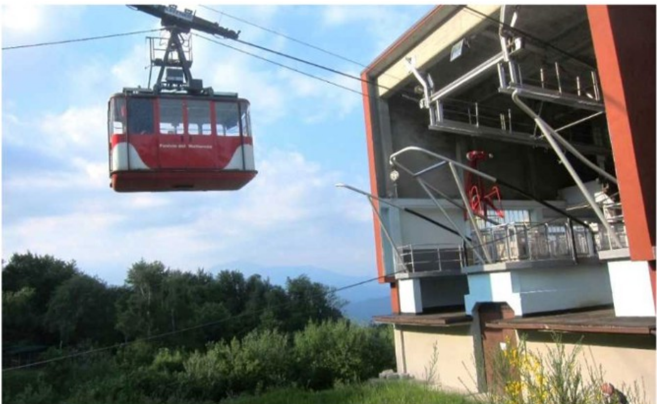
Abbildung 21: Station Alpino mit durch die Tragseilbremse gebremster Kabine Nr. 4 (Quelle: Digifema)
