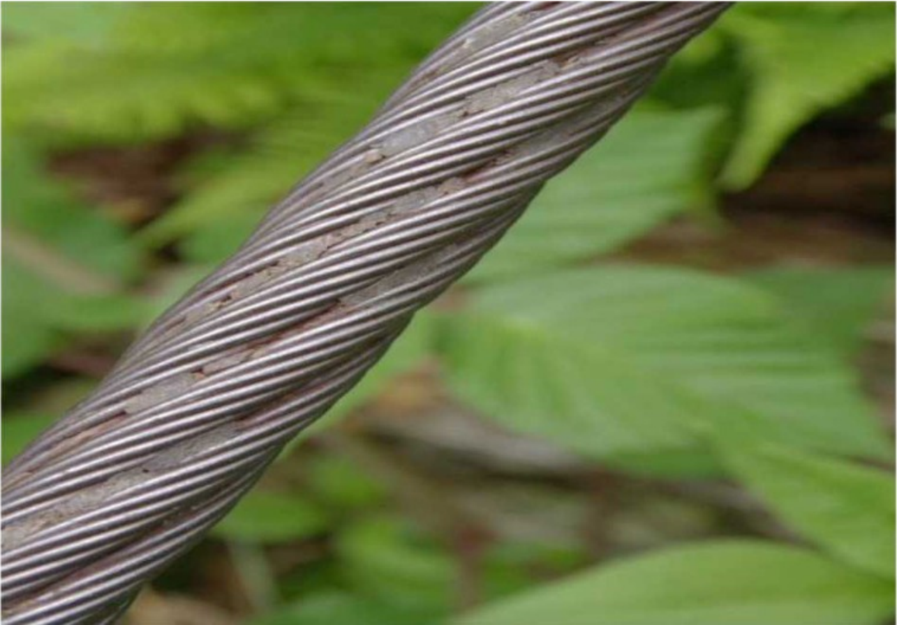
Abbildung 7: Gegenseil der Kabine 3 nahe der Absturzstelle (Quelle: Digifema)
