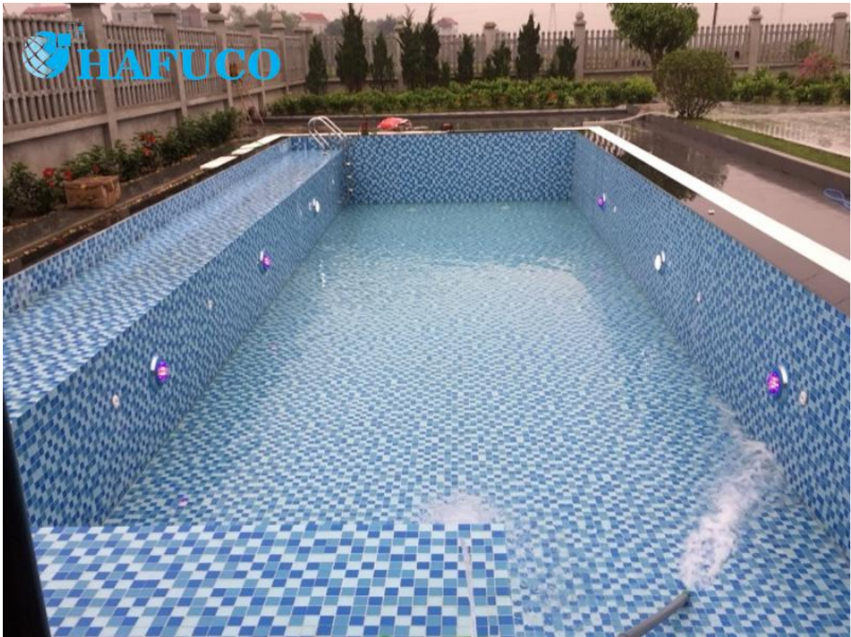
Thi công công trình bể bơi
