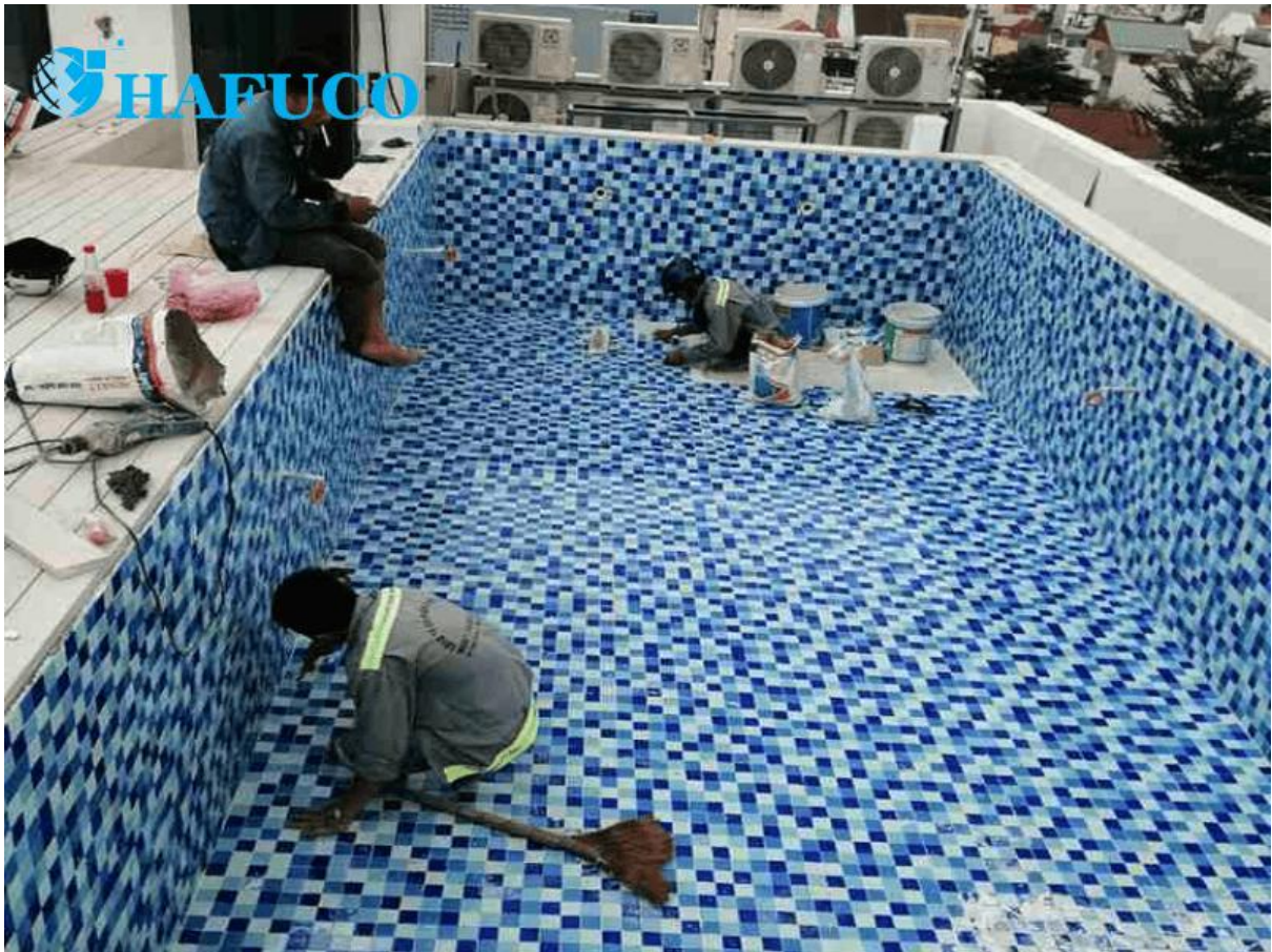
Thi công công trình bể bơi
