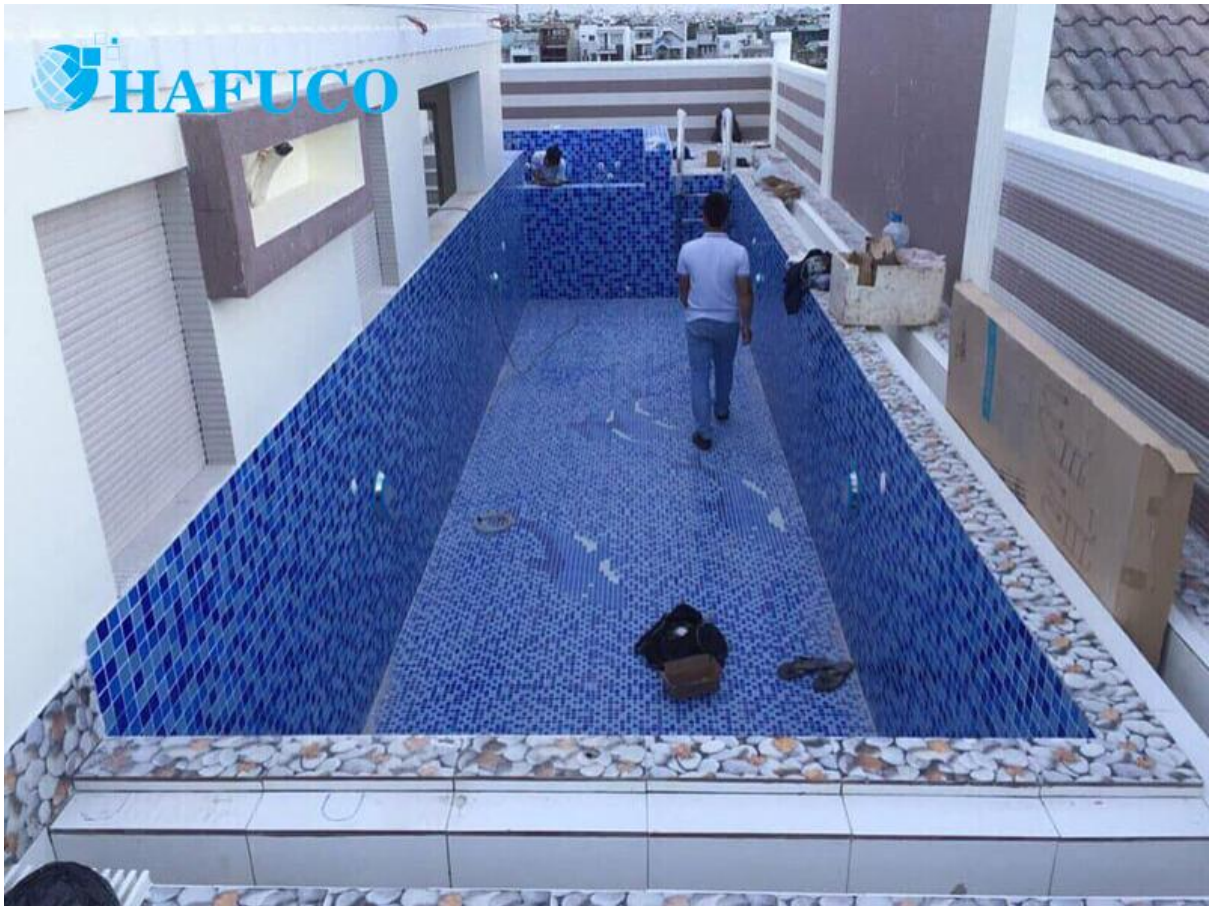
Thi công công trình bể bơi
