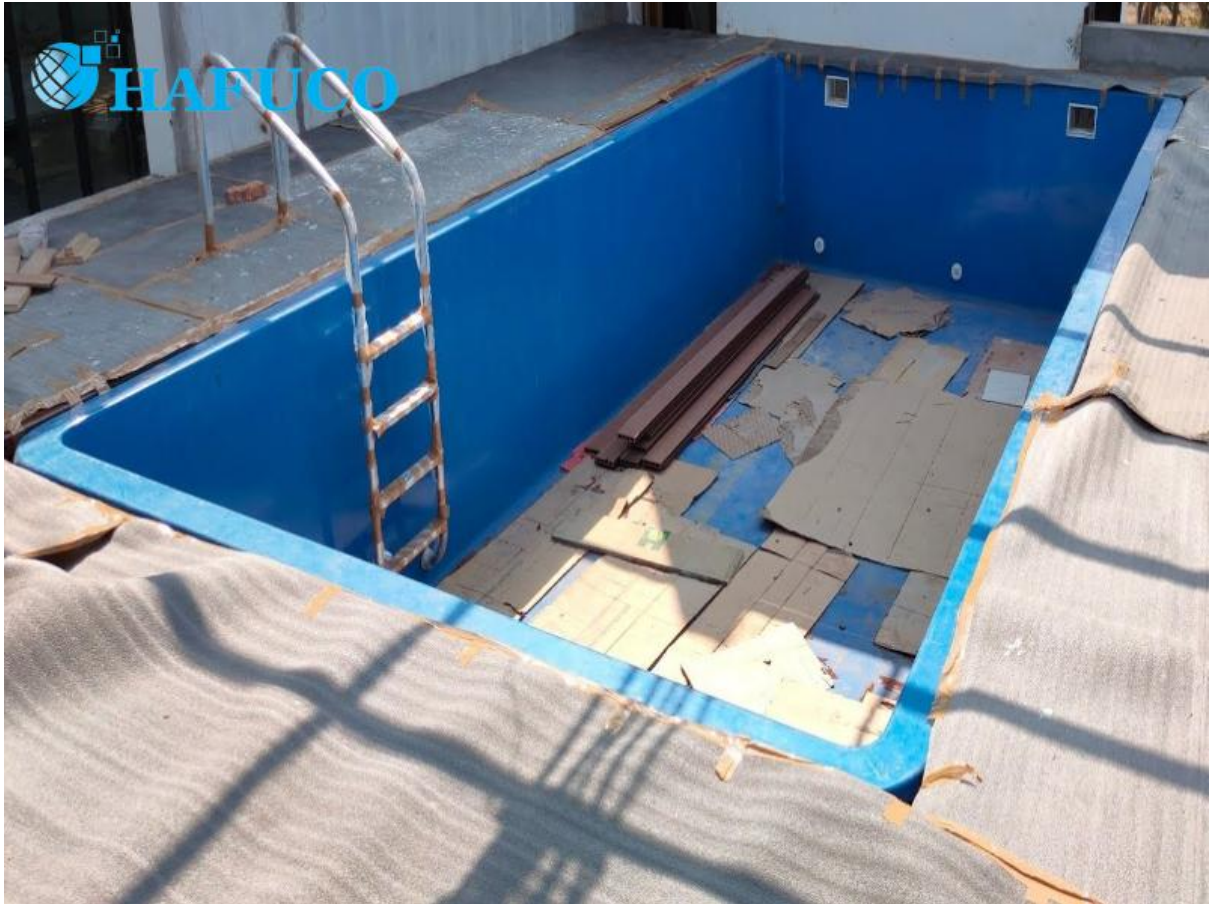
Thi công công trình bể bơi
