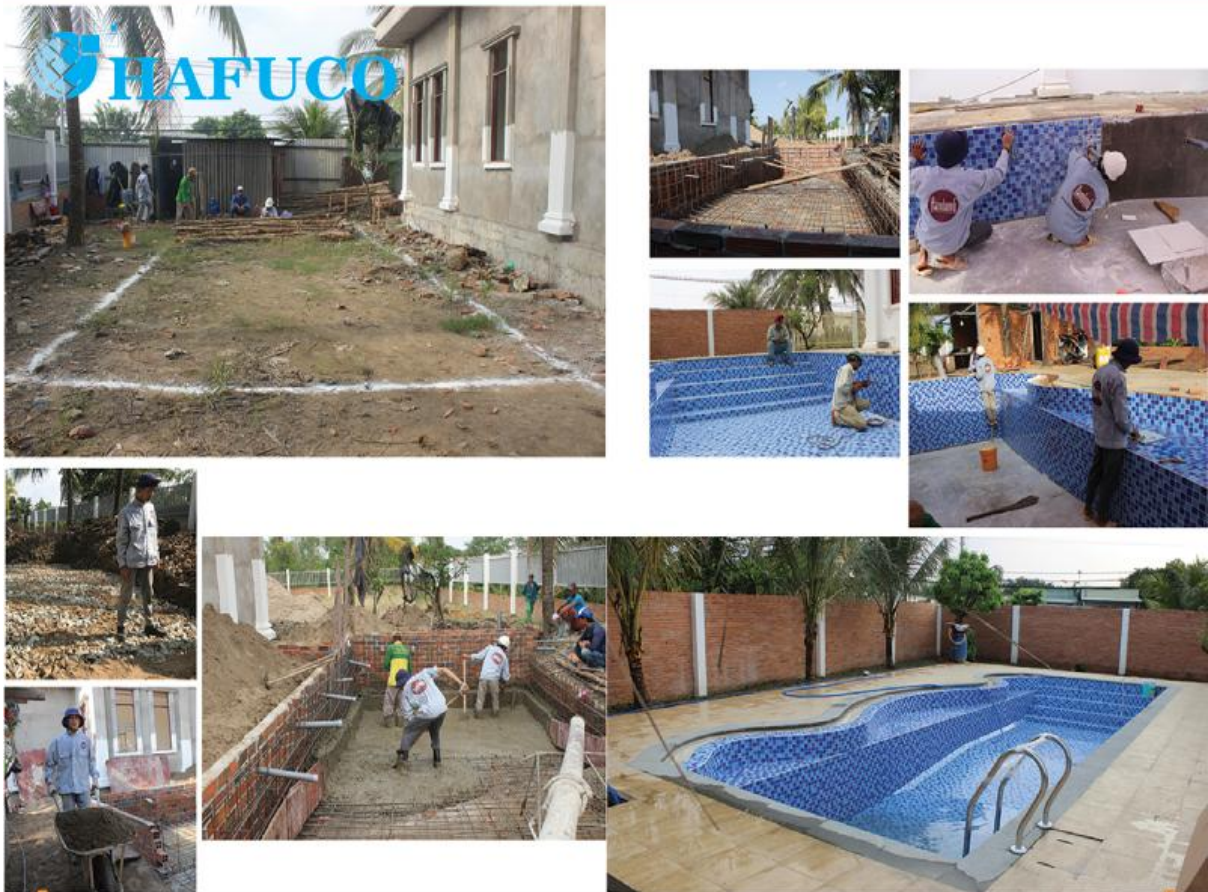
Các bước thi công
