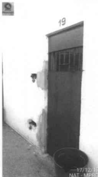
Foto 20: Pavilhão B – reposição do concreto segregado na porta.
