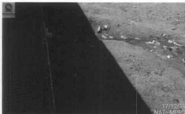
Foto 63: Pavilhão B – vazamento de suposto esgoto das celas.
