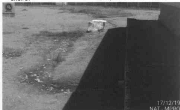
Foto 64: Pavilhão B – vazamento a céu aberto de suposto esgoto das celas.
