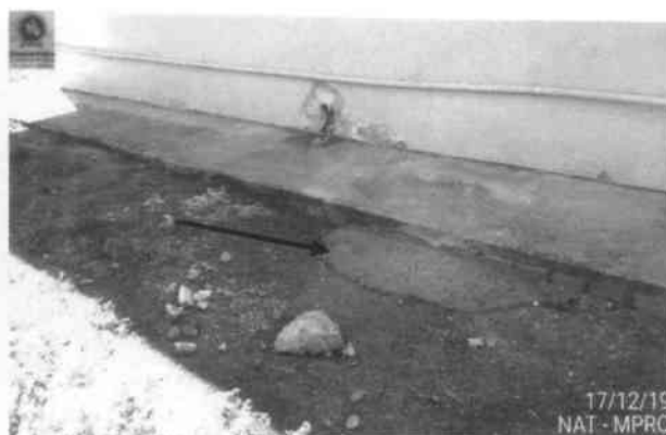
Foto 38: Pavilhão vivência – final do túnel no pátio do presídio, após a calçada do pavilhão.
