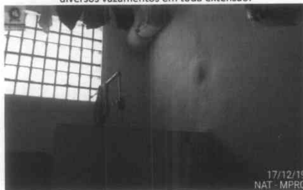
Foto 53: Pavilhão vivência – tubo em PVC, ligação para chuveiro, paredes internas com presença de mofo.
