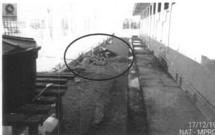
Foto 39: Pavilhão vivência – roupas com material (terra) proveniente da escavação do túnel.
