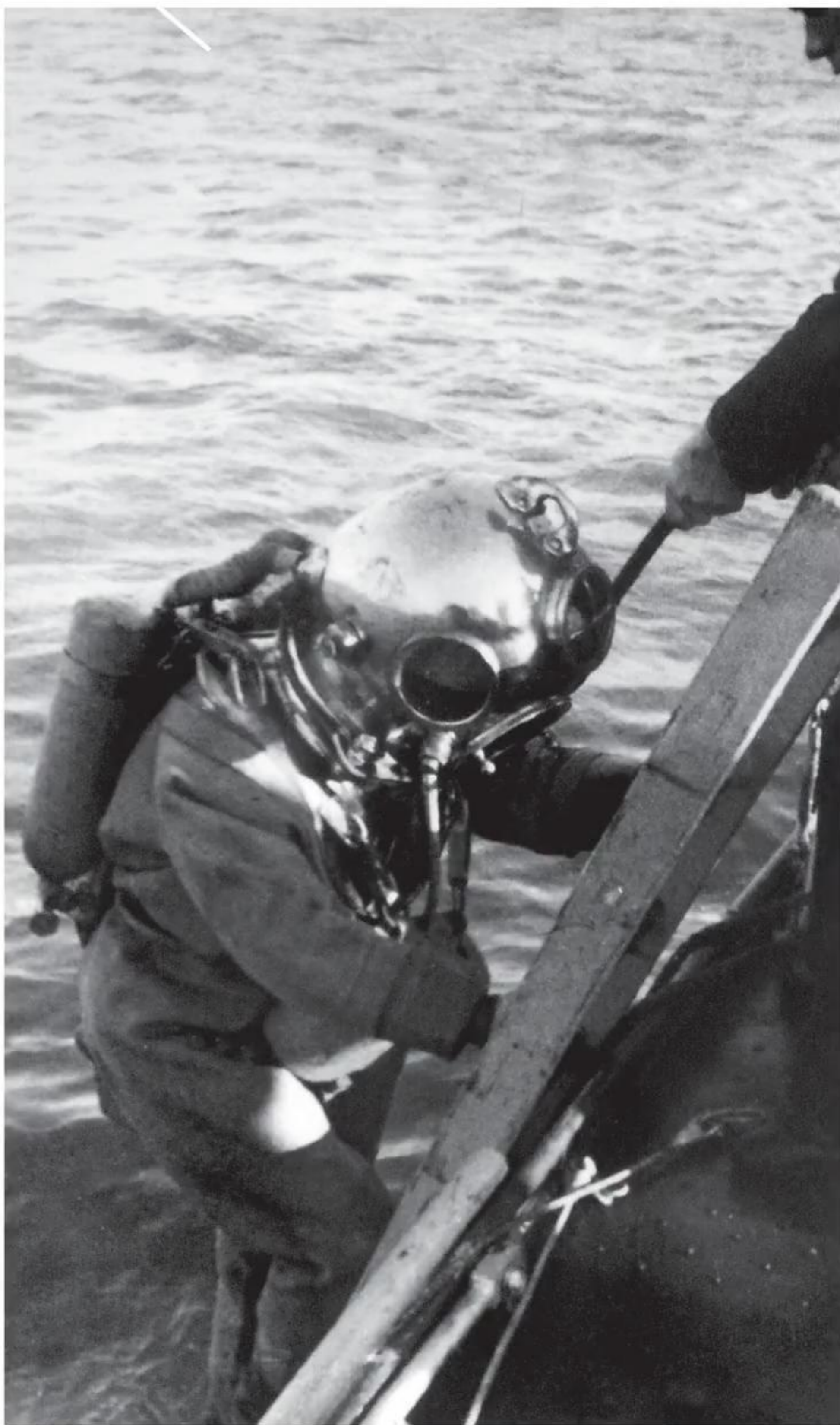
▲ Un marin du Karl Galster a revêtu un scaphandre et s'apprête à inspecter la coque du Zerstörer .
