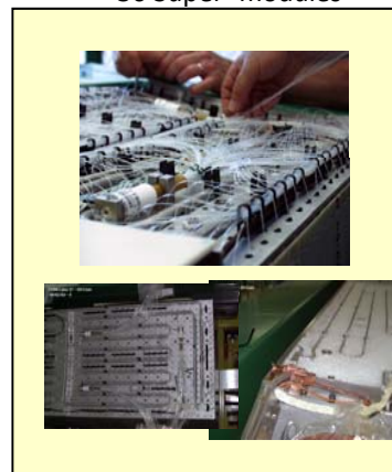
Installation du système de monitoring
