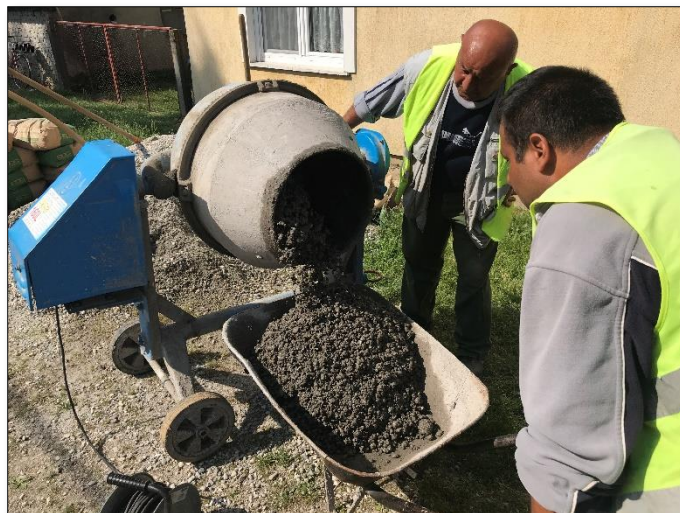
Betonkeverés a szegélyépítéshez
