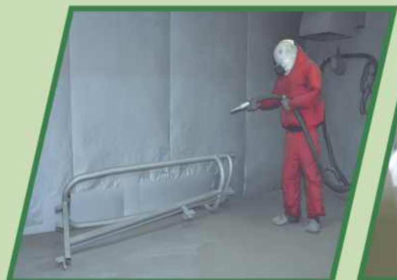
Jato de Granalha
