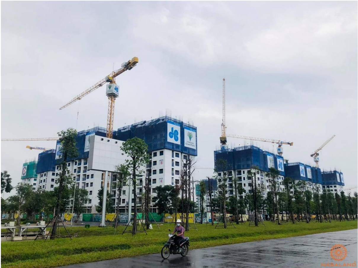
Tiến độ xây dựng dự án The Origami S6 15/12/2020
