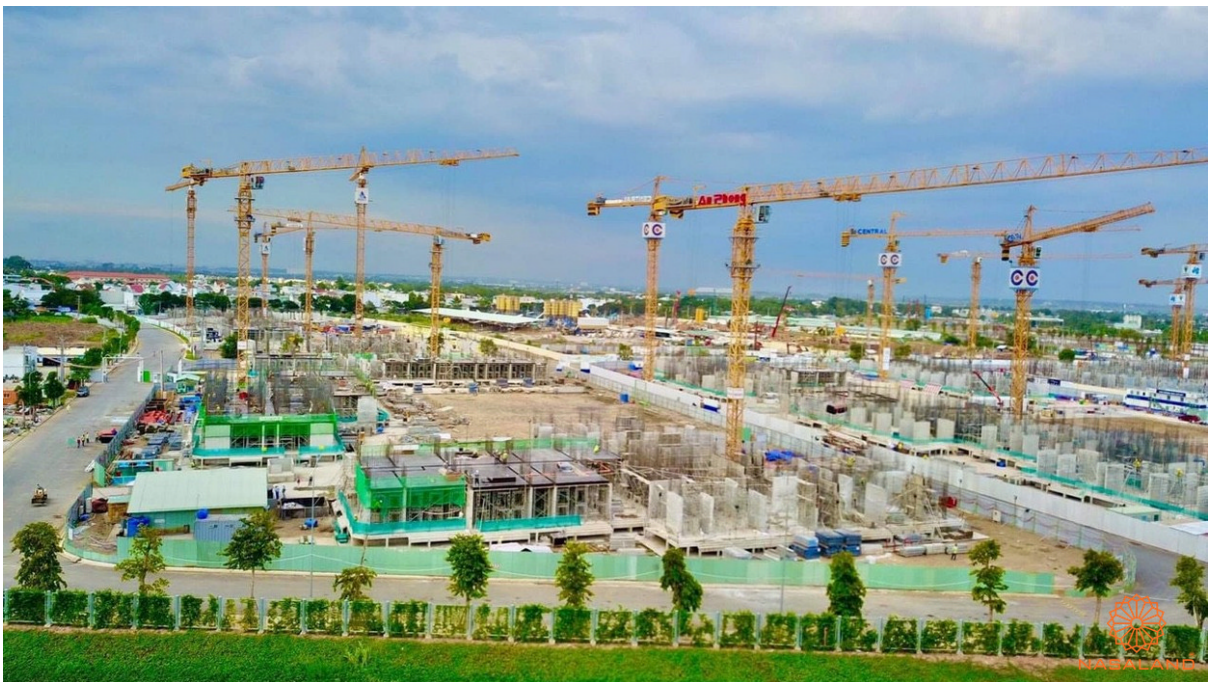
Tiến độ xây dựng dự án căn hộ The Origami 31/8/2020
