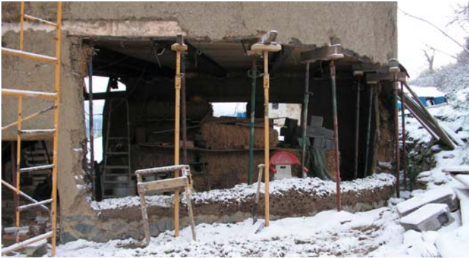
First section of wall demolished / Primera sección del muro demolida
