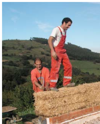
Setting a bale / Fijando una bala
