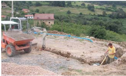
7/08: Foundation trench / Zanja de cimentación
