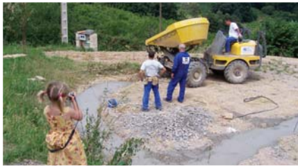
7/08: Pouring concrete ring beam / Echando viga corrida de hormigón
