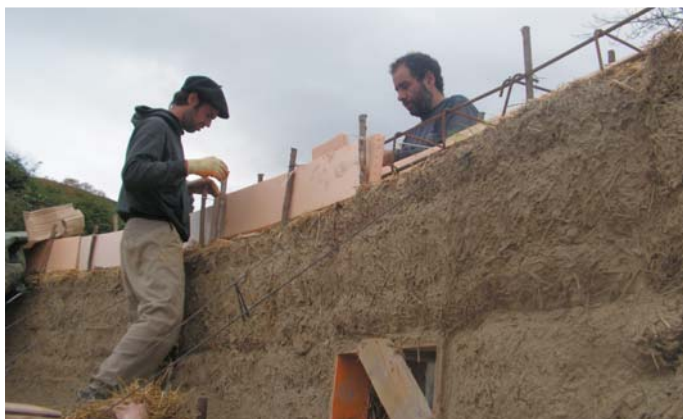
11/08: Formwork for concrete ring beam / Encofrado para viga corrida de hormigón
