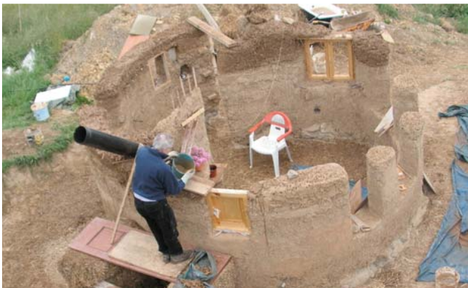
5/06: The wall going up / El muro seguía hacia arriba
