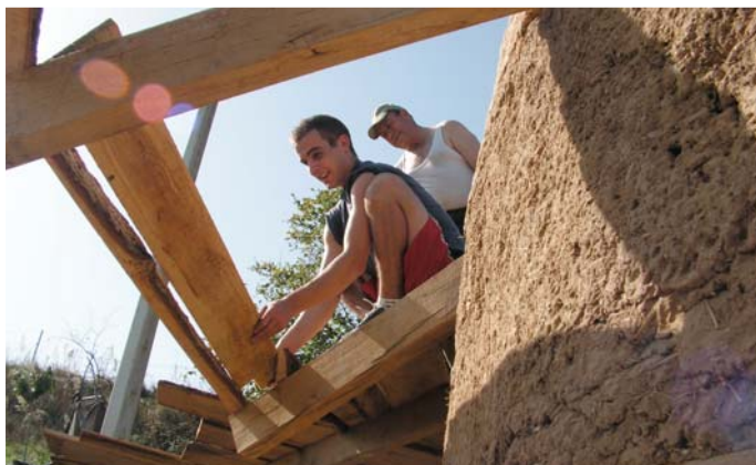
10/06: Cladding the roof with oaks boards/Poniendo tablas de roble encima de las vigas
