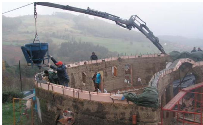
11/08: Pouring first-floor ring beam / Echando hormigón para zanja del primer piso
