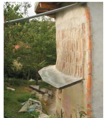
9/13: West wall tiled / Pared oeste con tejas
