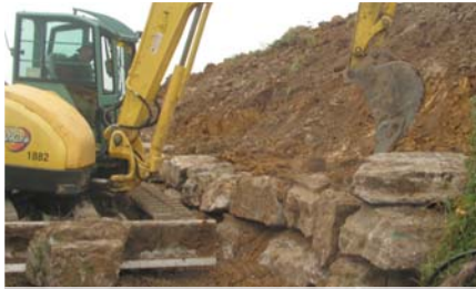
10/07: Earthmoving / Movimiento de tierras
