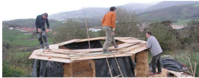
We built the walls & roof in one day / Construimos los muros & el tejado en un solo día
