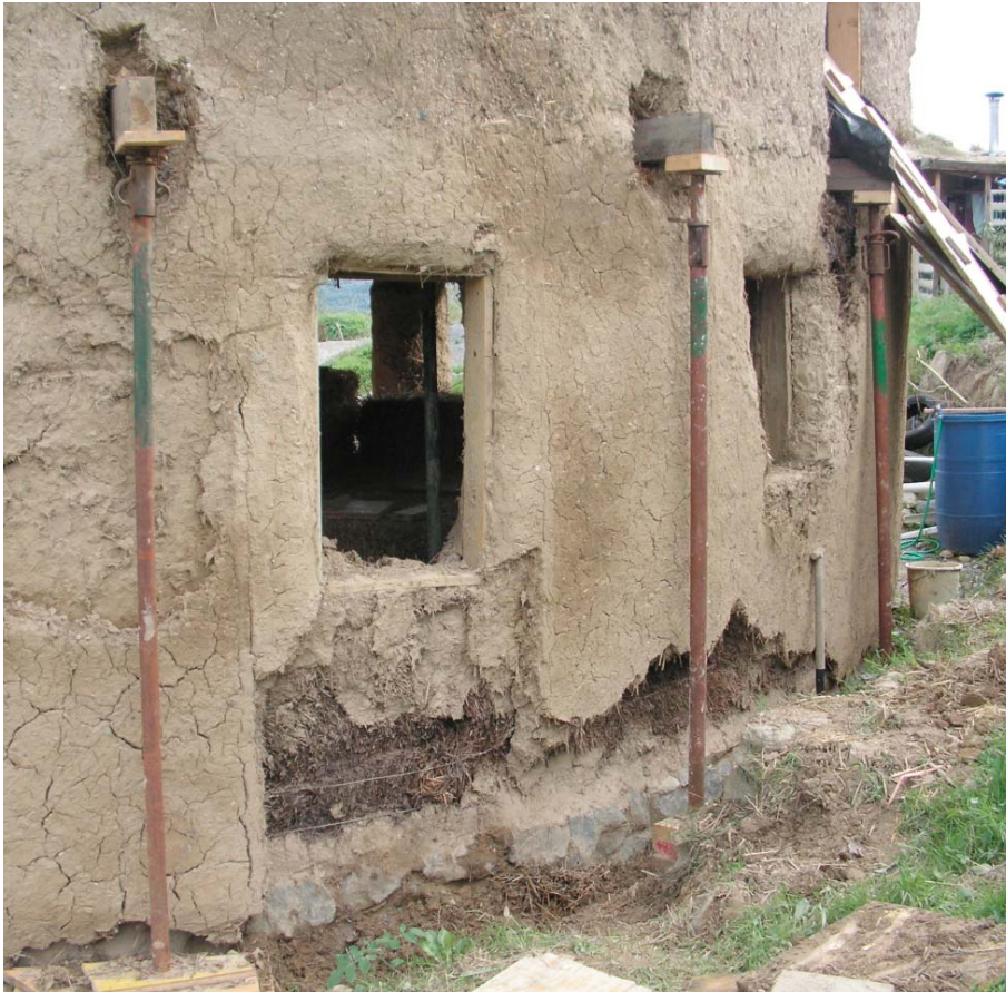
11/09: Water damage to straw bale wall / Muro de balas de paja dañado por agua
