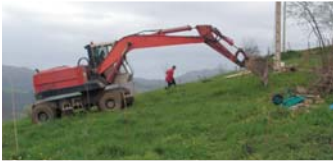
3/06: Earthmoving / Movimiento de tierras
