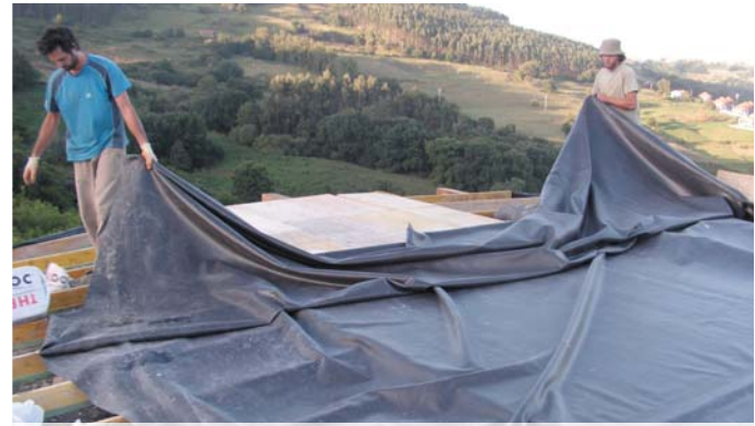
7: Laying out the rubber membrane / Poniendo la membrana de caucho
