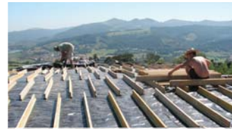
5: Roof battens / Viguetas del tejado
