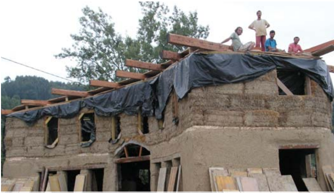
4: Wall complete, roof beams in place / Muro terminado, vigas puestas
