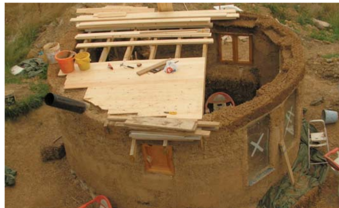
6/06: Laying the loft floor / Poniendo el suelo del atillo
