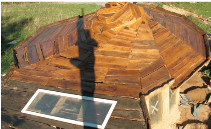
11/06: Roof cladding finished / Tablas del tejado puestas
