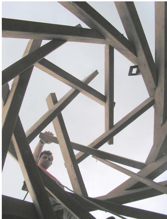
11/06: Building the second reciprocal frame / El segundo marco recíproco
