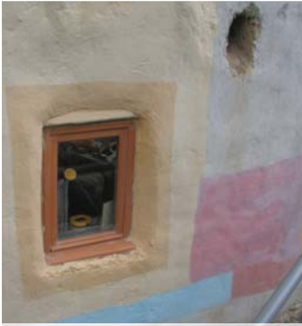
10/12: Lime paint test / Probando pintura de cal
