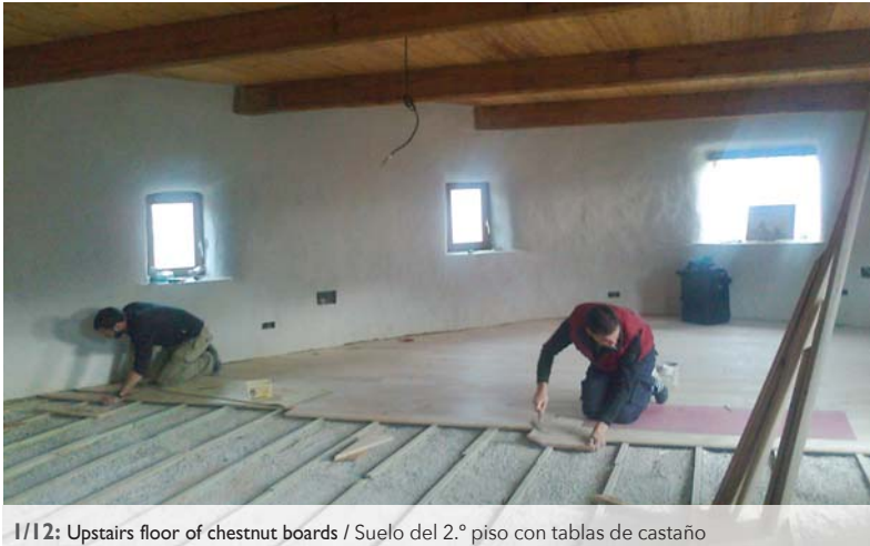
11/12: Upstairs floor of chestnut boards / Suelo del 2.º piso con tablas de castaño
