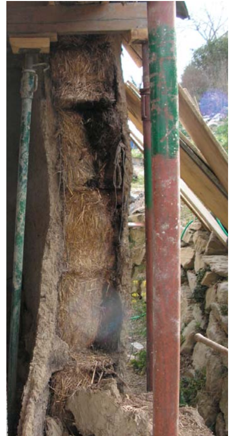
11/09: Water damage to straw bale wall / Muro de balas de paja dañado por agua
