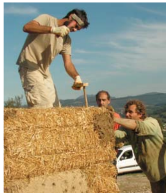
Staking a corner / Estacando una esquina
