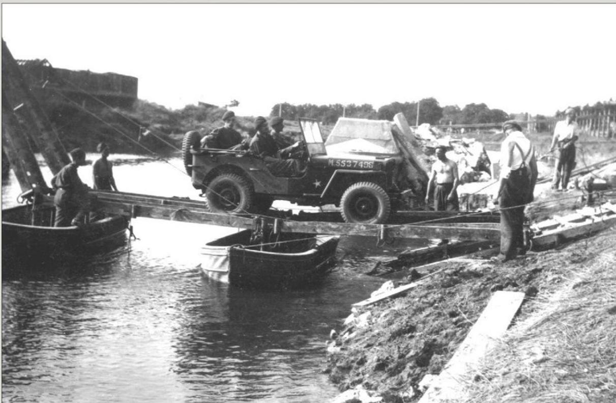
Une Jeep de la compagnie du génie traverse la Touques, en Normandie, sur un pont flottant. Matraqués par l'aviation alliée, sabotés par les Allemands en retraite, À la mi-1944, dans le pourtour de la Normandie, rares étaient les ouvrages d'art encore en état de supporter le passage de véhicules, y compris parmi les plus légers !
