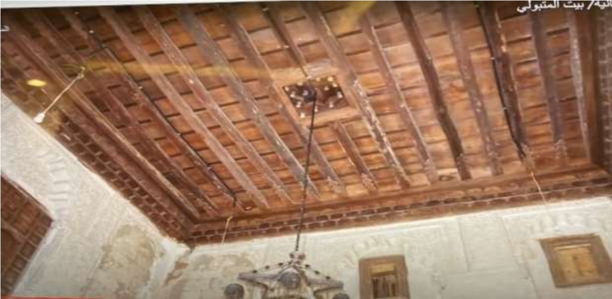
أحد أسقف بيت ومتحف المتبولي الخشبية (المصدر: فيديو يلا نتمشى)
