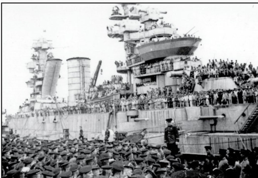
Un meeting organisé à bord du Parizhkaya Kommuna à l'occasion de l'achèvement des travaux de remise en état en avril 1942.
