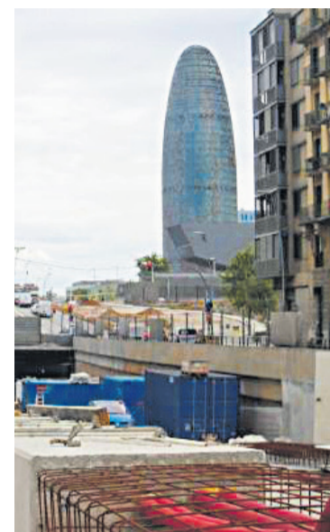
La construcció del túnel de Glòries a Barcelona, que es va fer entre pantalles / ACN
