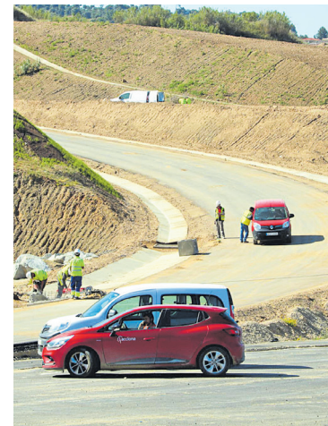
Obres en un tram de la B-40 / ACN
