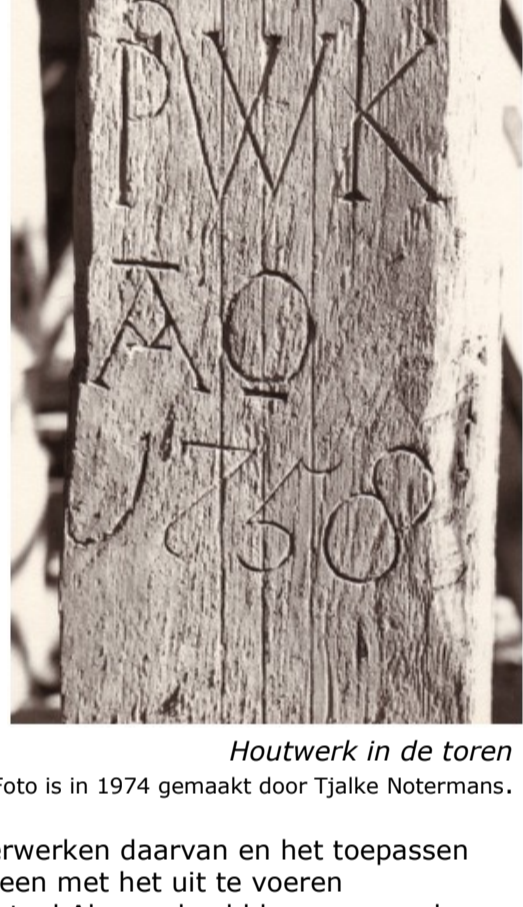
Houtwerk in de toren
