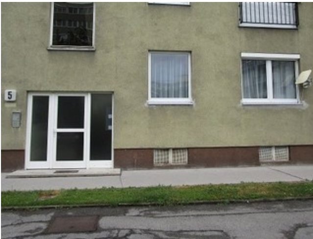
Haustür Stiege 5, Kinderzimmerfenster, Schlafzimmerfenster
