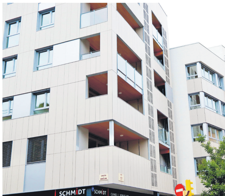
L'edifici de la carretera de Barcelona, acabat i durant les obres / AINA TORRES / V.R.
