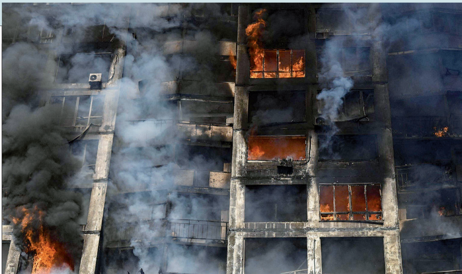
Un edificio residenziale in fiamme a Kiev dopo un attacco russo che ha provocato almeno due vittime / Afp
