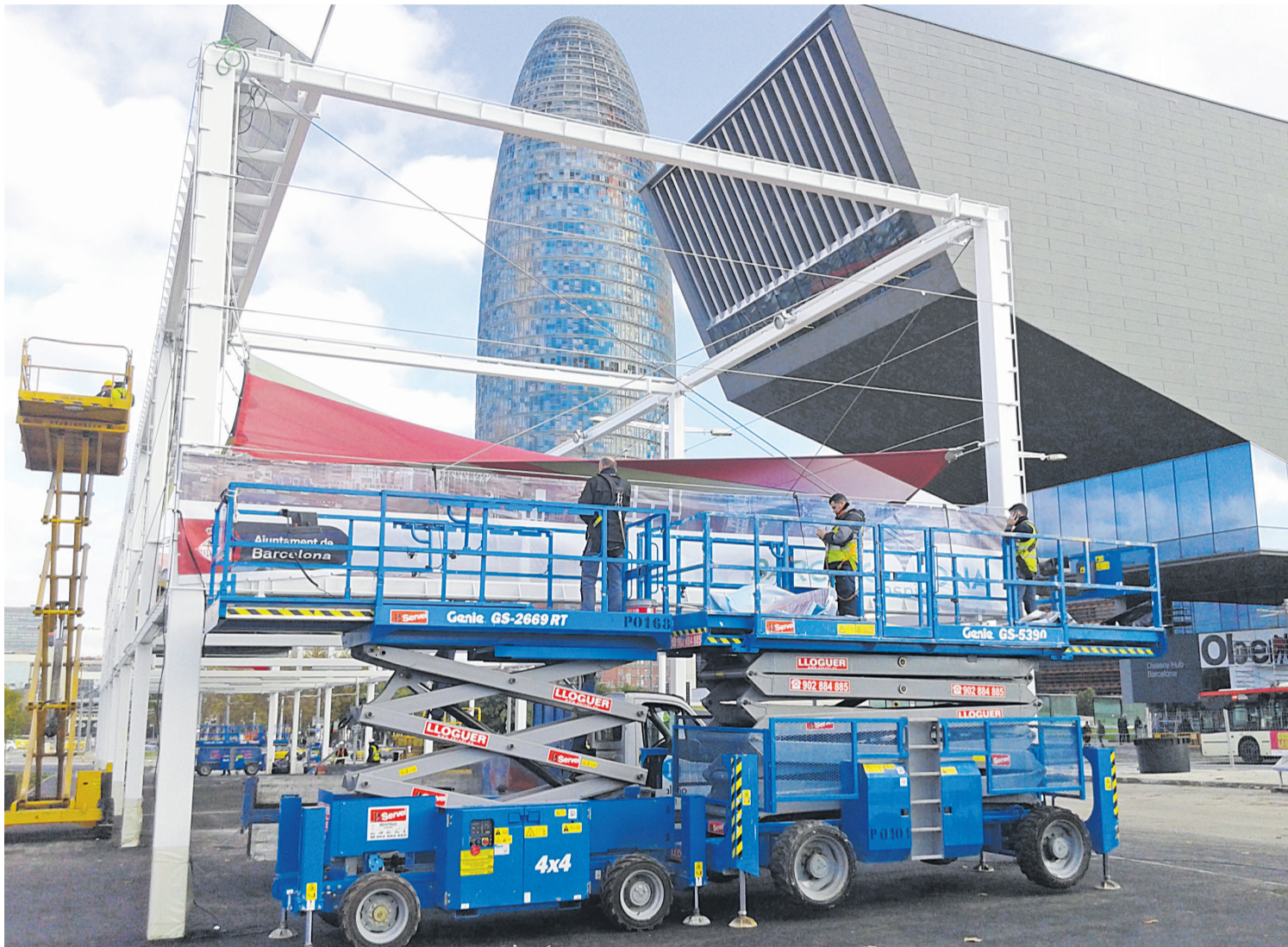
Maquinària de Servei, a la Torre Agbar / CEDIDA
