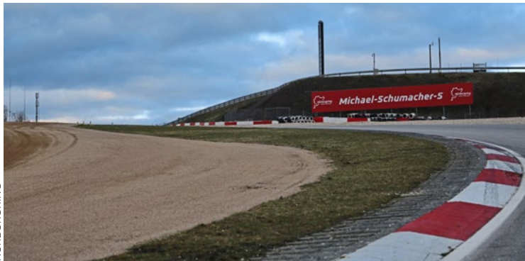
Blick auf den neuen Schotterabschnitt neben dem Schumacher-S
