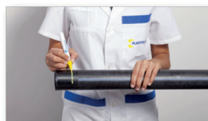
Marcare la profondità d'inserimento.
