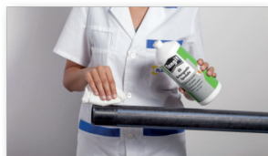
Limpiar las superficies con el detergente idóneo.
